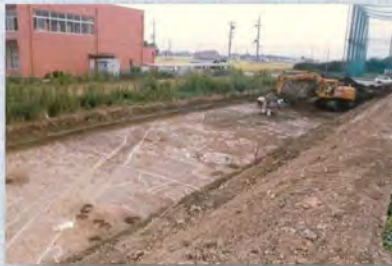
目田川改修工事の様子 (S59)
