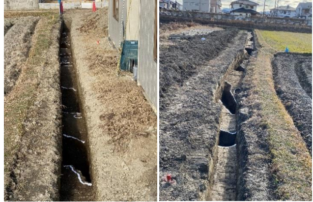
擁壁工事箇所での調査の様子
