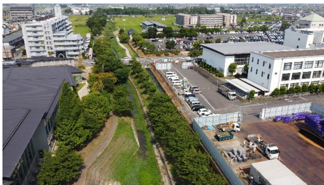
河川改修後の目田川の様子（左の建物は図書館）
