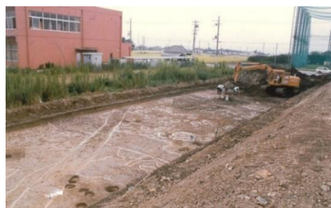
上：第6次調査（1984）航空写真 下：調査風景（左の赤い建物は図書館）
